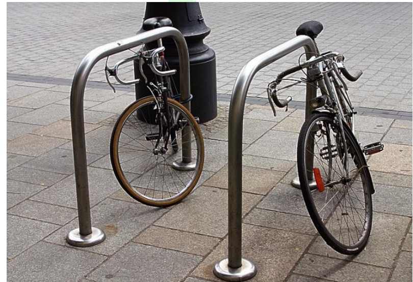
Źródło: Fotorzepa, Parking dla rowerów. Pałak jest gruby, nie da się go przepiłować, Seweryn Sołtys
