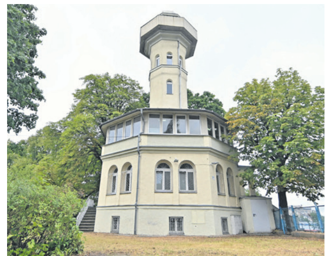
Widok współczesny - 18-metrowa Wieża Braniborska w Zielonej Górze
