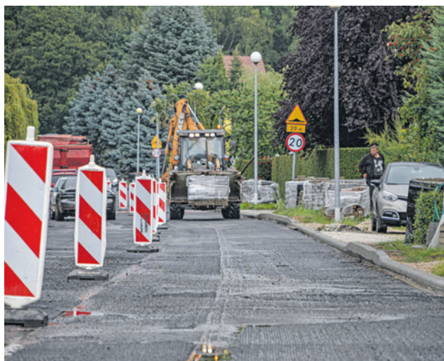
Remont ul. Jagodowej przesunięto do końca września. Przyłączą się nieprzewidziane prace dodatkowe wynikające z budowy sieci wodociągowej.
