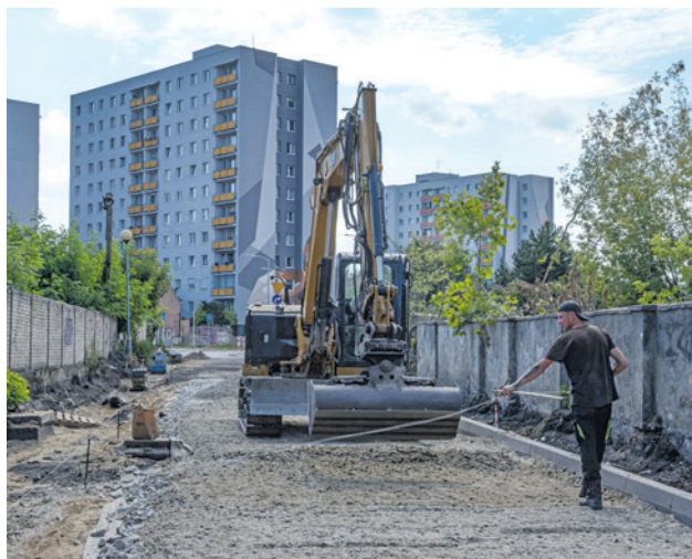
Do połowy października potrwa budowa ulic Węglowej, Rymarskiej i Składowej. To dawne gruntowe drogi. Teraz będą miały nawierzchnię z ekokostki.
