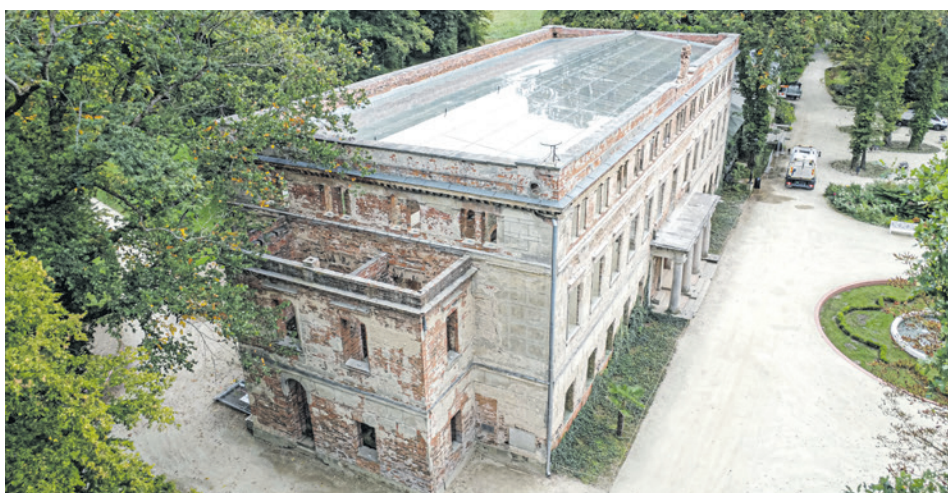
Szklane tafle dachu mają sześć milimetrów grubości. Widać je tylko z wnętrza ruiny albo z lotu ptaka.
