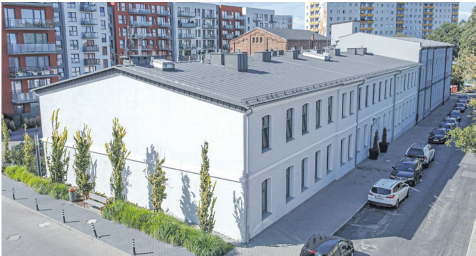
Lubuski Mister Budowy 2025 w kategorii zabytkowe obiekty budowlane - Lisia 10, adaptacja dawnej fabryki sukna. Inwestor i wykonawca EBF Development Elżbieta i Leszek Jarząbek. Projektant: Wojciech Krzywoszański
