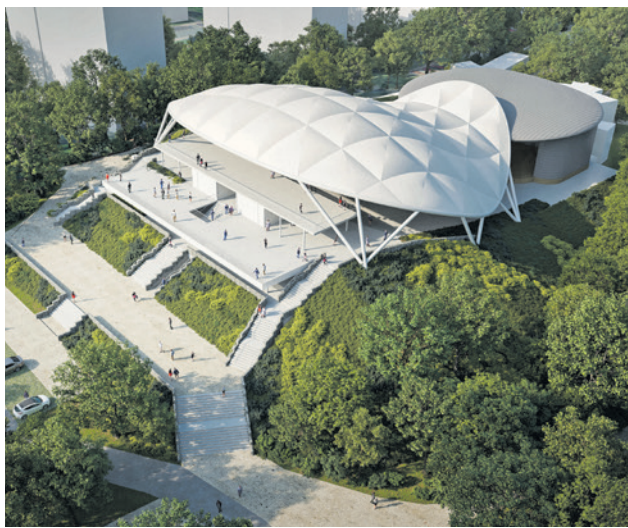
Modernizacja obejmie m.in. przebudowę widowni i budowę nad nią nowoczesnego zadaszenia z membrany
