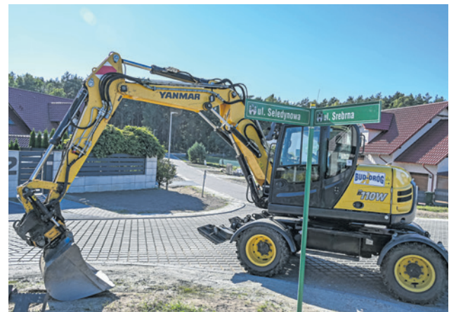
Srebrna i Seledynowa będą mieć nawierzchnię z kostki betonowej
