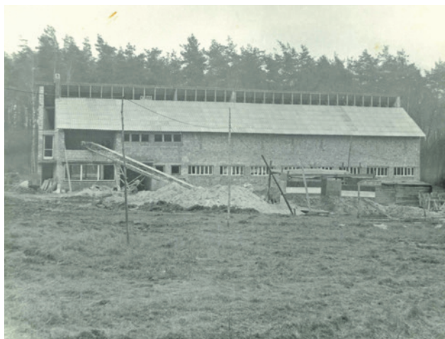
1973 r. Ośrodek jeździecki w Raculce w budowie.
