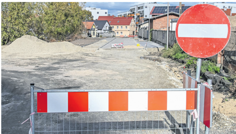
Ulica Węglowa jest już praktycznie gotowa. Wykonawcą inwestycji jest Sakuta Group.
