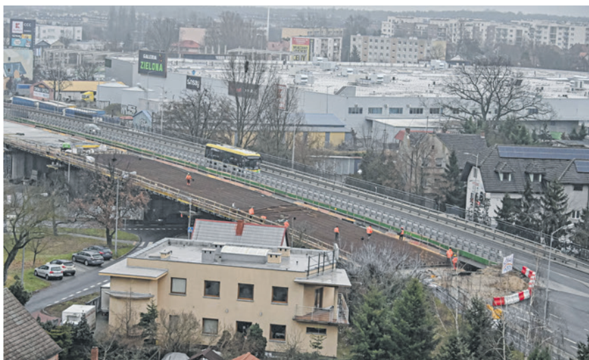
Trwa zbrojenie ustroju nośnego na ostatnim odcinku wiaduktu
