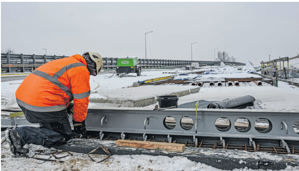
Na pierwszym odcinku wiaduktu trwa m.in. zbrojenie chodników
