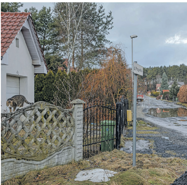
Kanalizacja wraz z tzw. odgałęzieniami do granic posesji będzie zrobiona m.in. na ul. Drzonków-Pogodna FOT. WŁADYSŁAW CZULAK
