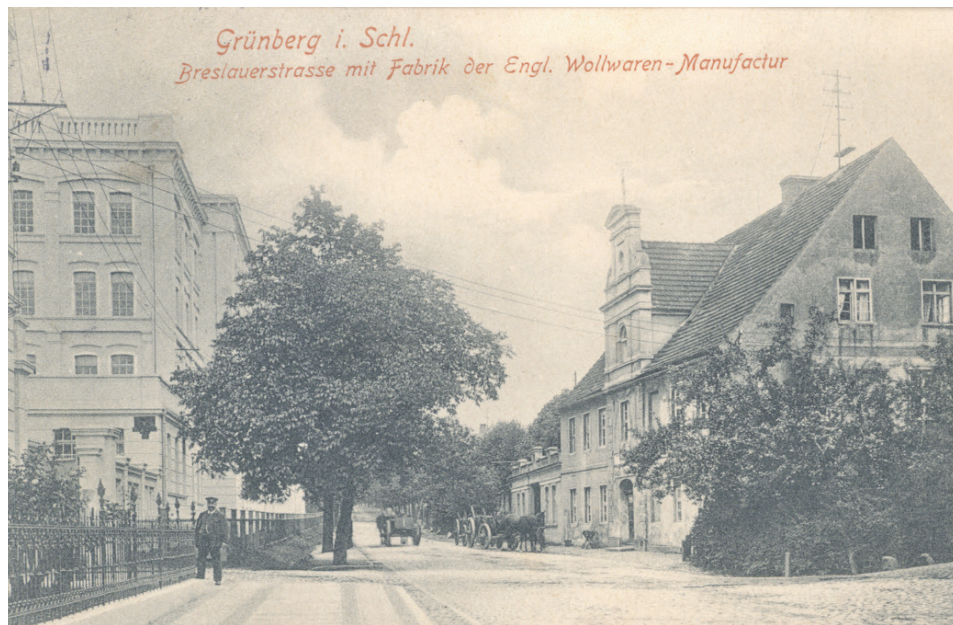
Ul. Wrocławska z nieistniejącą fabryką włókienniczą
