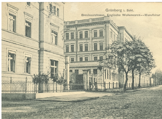
Fabryka przy ul. Wrocławskiej została zburzona w 1936 r.
